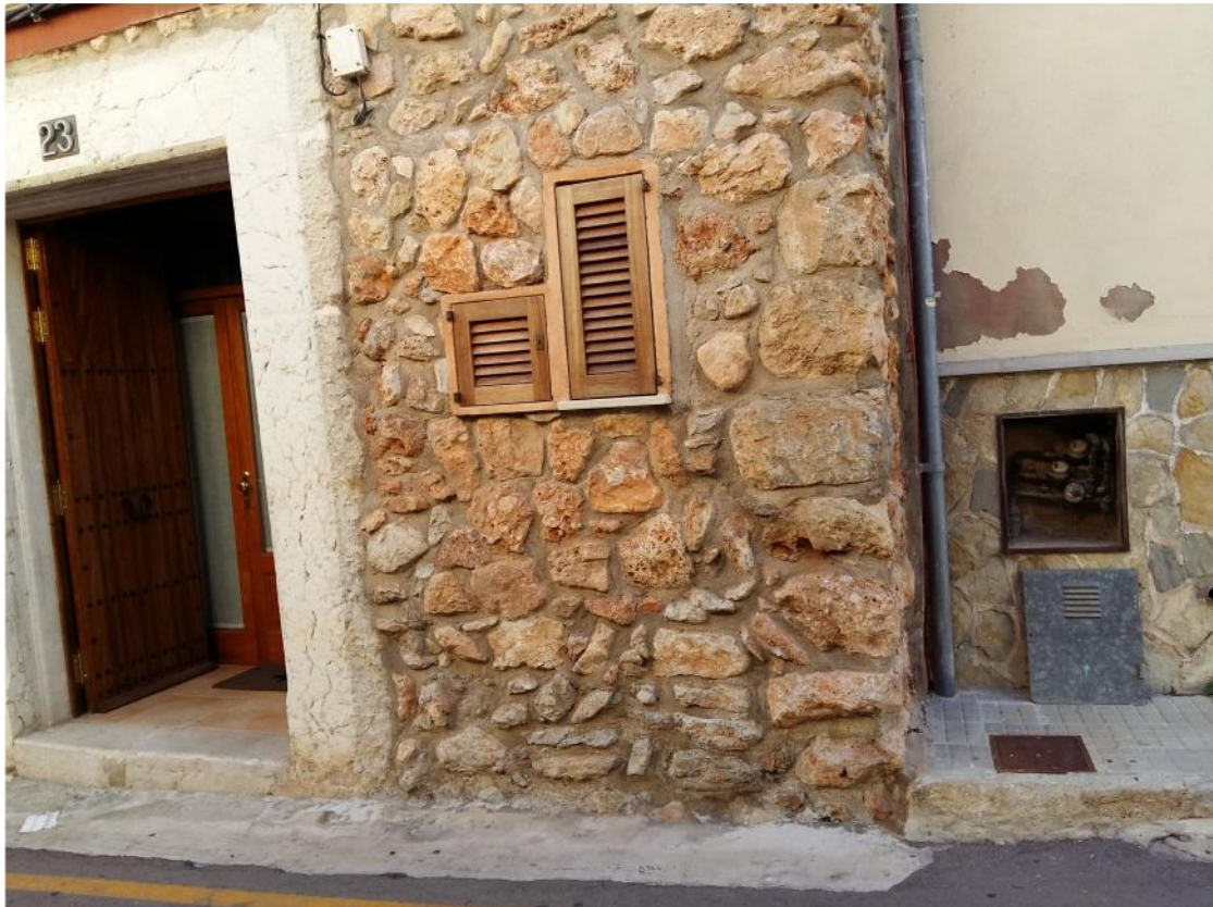
Foto 5: Vista contadores abastecimiento en intersección con C/ Verge del Refugi
