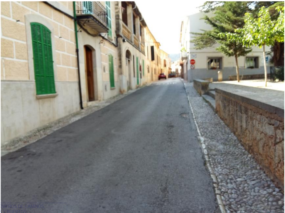
Foto 10: Detalle acera-cuneta en Plaza del Mercat
