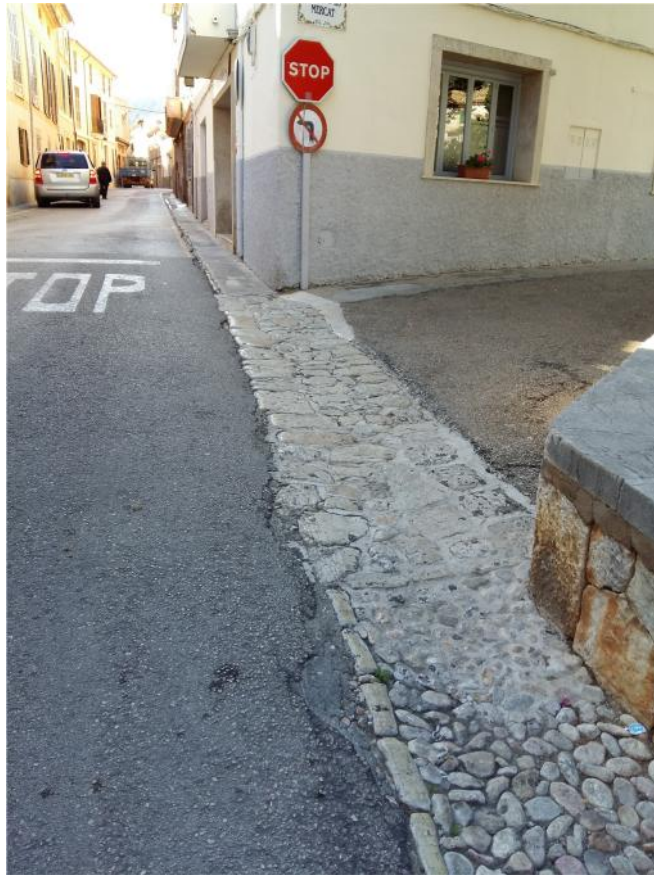
Foto 11: Detalle acera-cuneta en Plaza del Mercat
