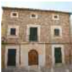
Bei der Renovierung von Son Guitard (18. Jhd.) wurde die Natursteinfassade freigelegt
