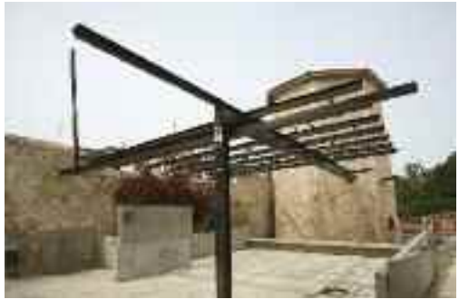
Torre de la Electricidad
