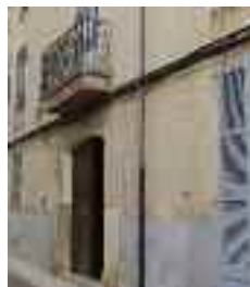
Can Bereiol, Sitz des Elektrizitätswerkes (Gebäude neben dem Turm)
