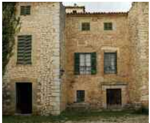
Fassade von Son Curt
