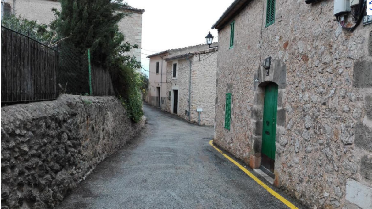
Foto 1: Inicio calle Son Sant Joan. Suministro de servicios por tendido aereo
