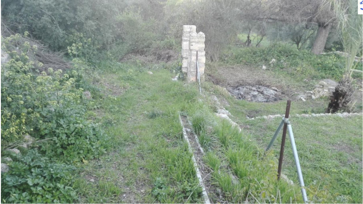
Foto 5: c/ Son Sant Joan – fachada número 14. Cerramiento sin malla metálica, pilastras entrada.
