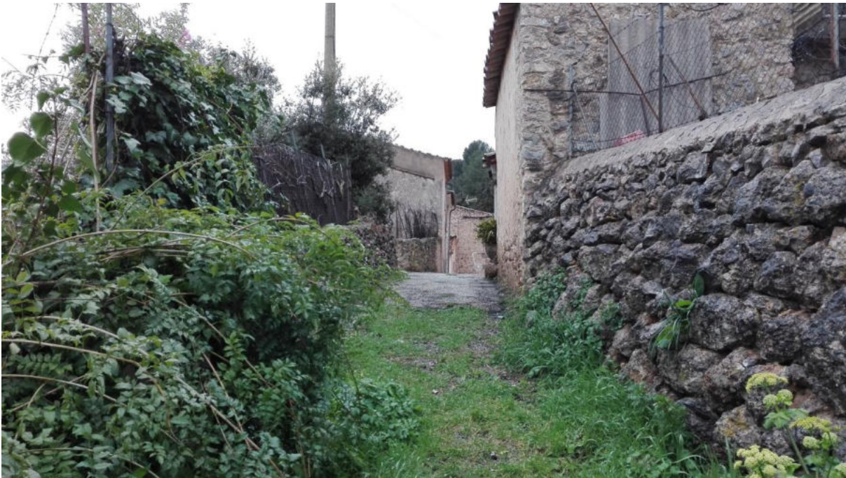
Foto 4: c/ Son Sant Joan – pavimento asfaltico post tensa eléctrica en linde solares num.12 y 14
