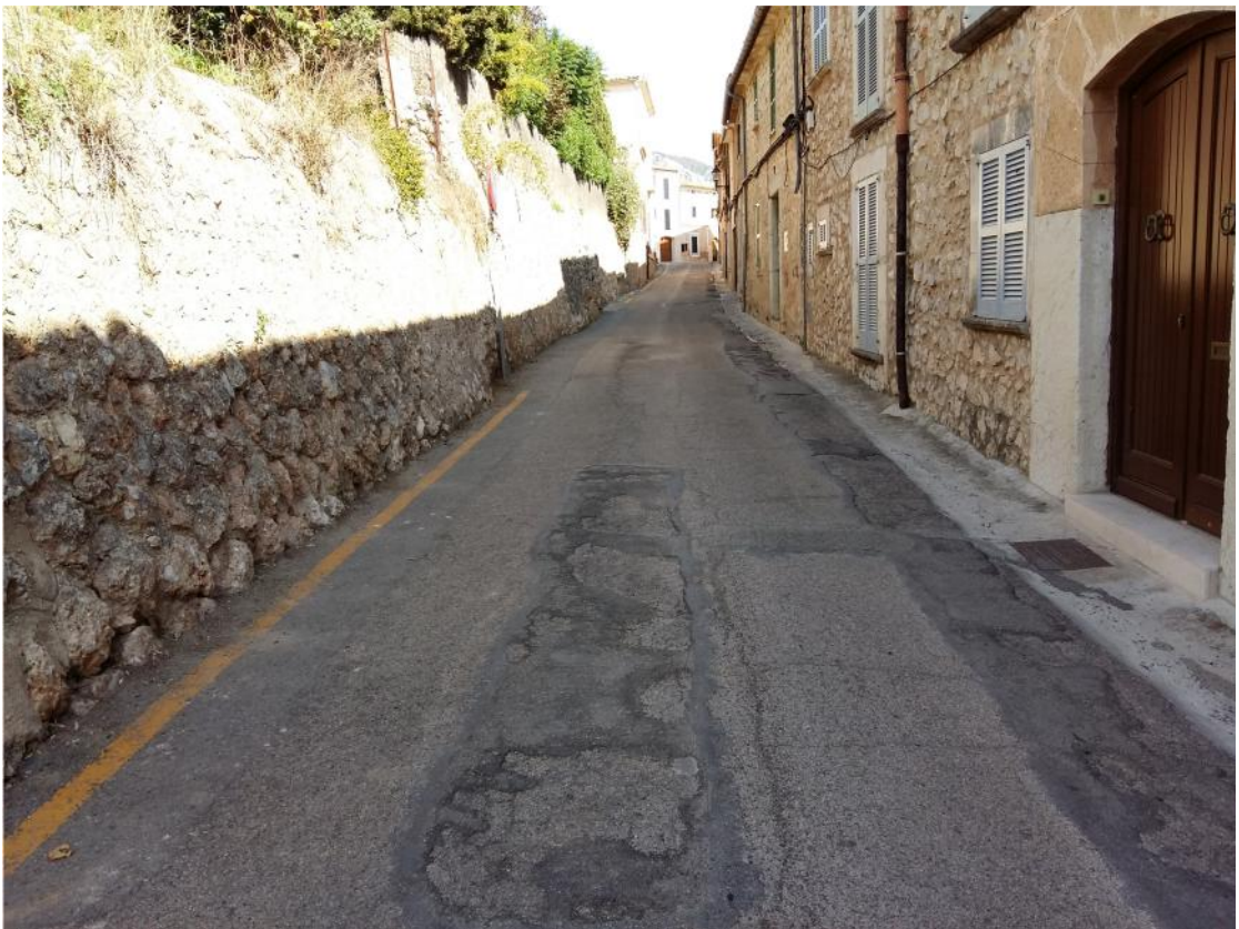
Foto 10: Vista hacia calle Solleric
