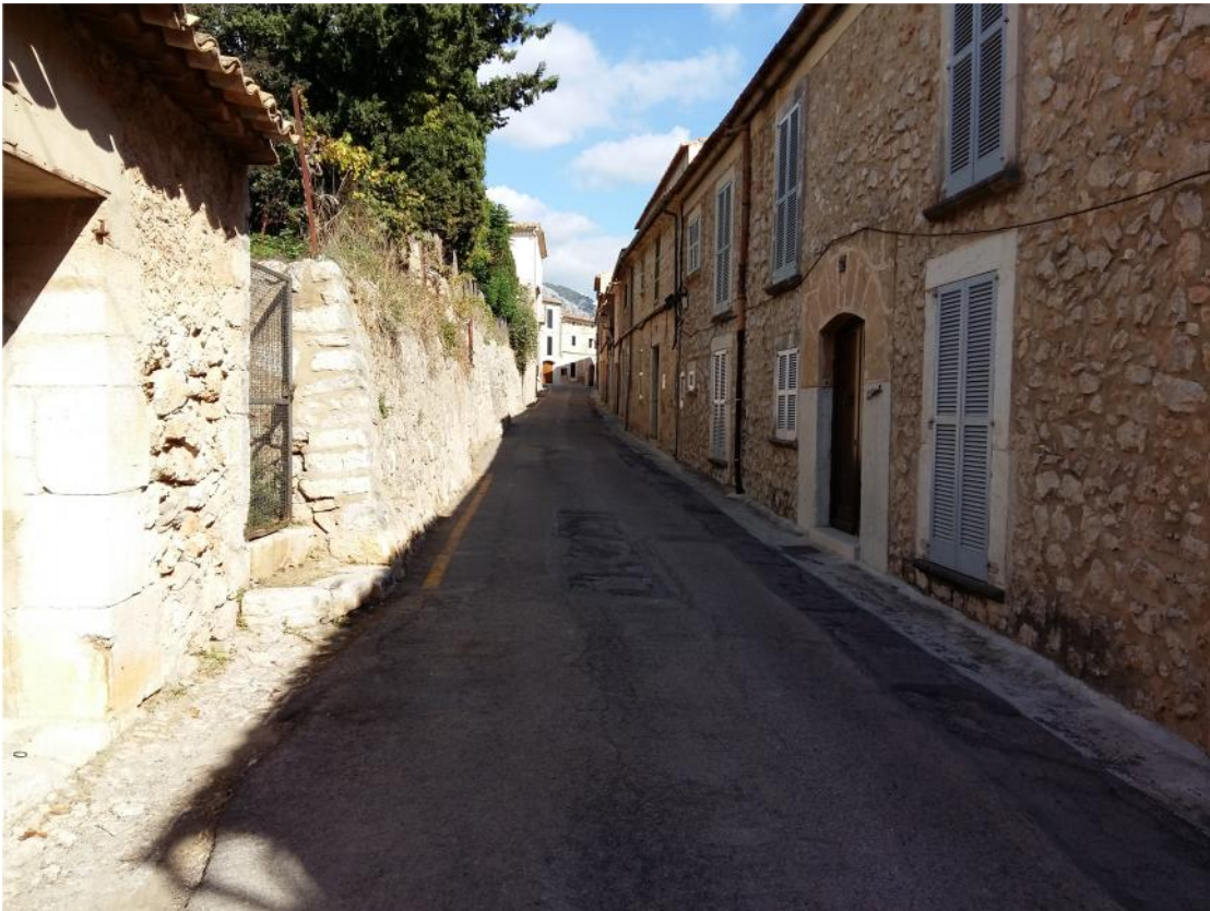
Foto 8: Detalle estrechamiento de sección. Desaparece la acera - cuneta
